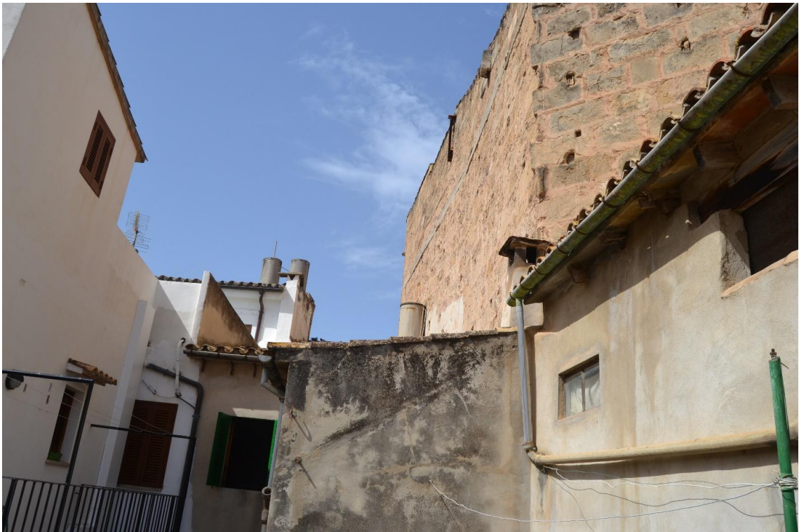
Interior vivienda colindante. Patio
