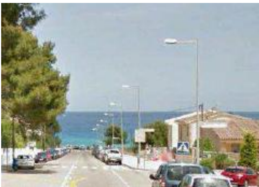
Farola tipo Av Cavall Bernat baculo 8 metros con tubo fluorescente a 4 metros.
