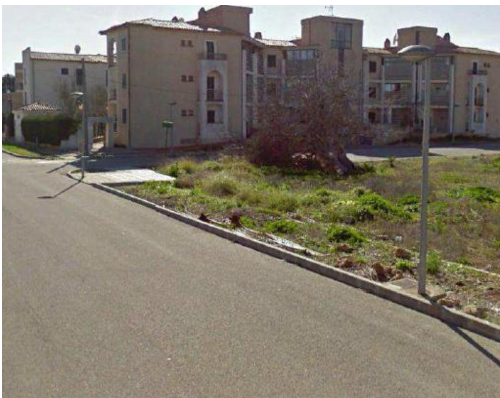
Farola tipo Llenaire, estado actual.
